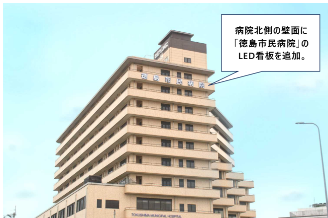
病院北側壁面
