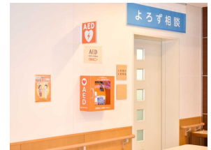
1階総合受付横に設置の1台
