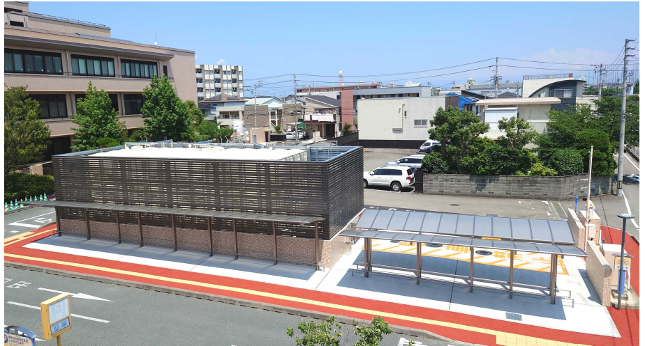
当院敷地内南側に完成した据置型受水槽（画面左）及び貯油槽（画面右 駐輪場奥、黄の斜線部分地下）
