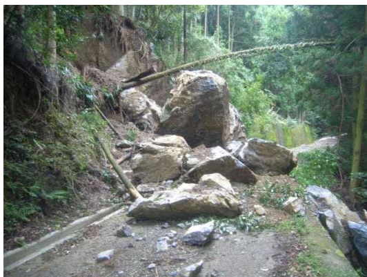
斜面崩壊の状況（平成 28 年 9 月） 飯谷町
