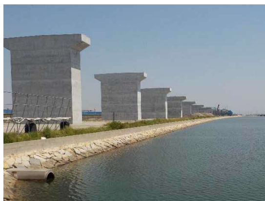
整備中の四国横断自動車道 沖洲付近
