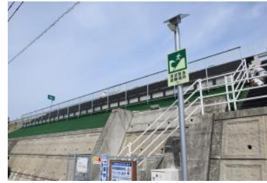
津波避難施設
