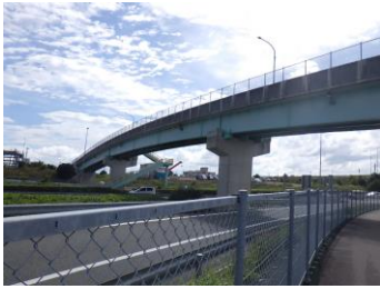
橋りょうの耐震補強
