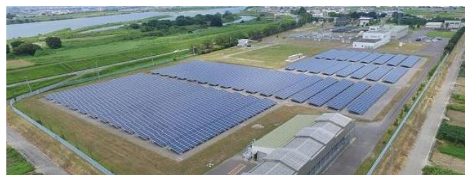
太陽光発電設備（第十浄水場）
