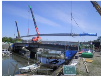
橋りょう添架管架替工事
