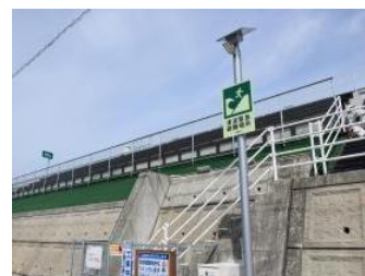
津波避難施設
