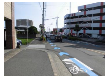
自転車走行空間整備
