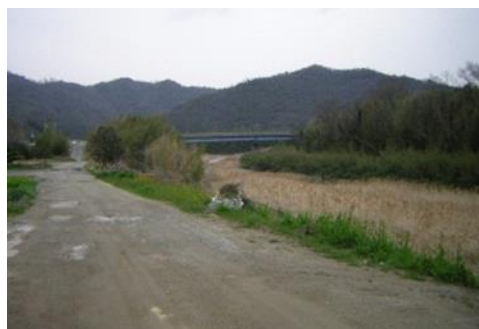
【園瀬川】川西地区・明善地区の堤防整備及び上中筋地区の漏水対策の促進
