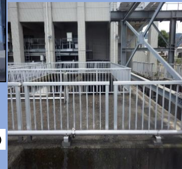
② ポンプ場設備増設(加茂地区)
