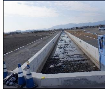
① 雨水排水施設整備(川内地区)
