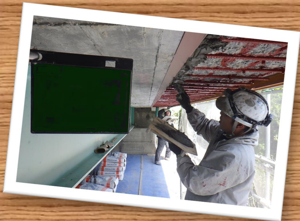
橋りょうの断面修復工事(施策20)
