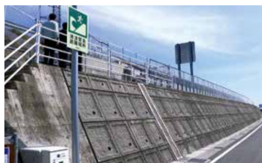
▲加賀須野地区の津波避難施設
