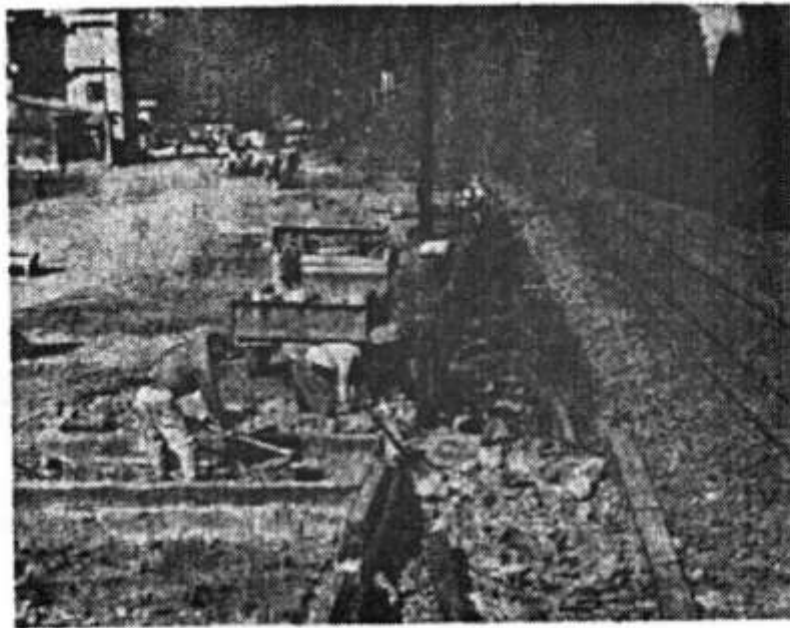
はじめた立体交差路の新設工事
