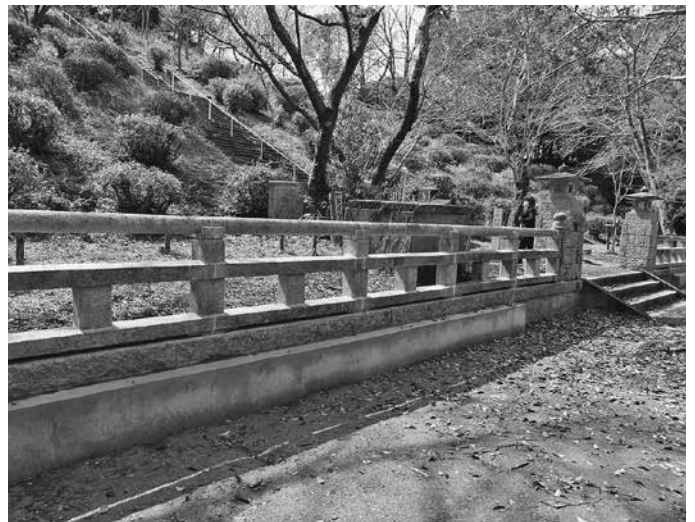
忠霊塔玉垣修復
