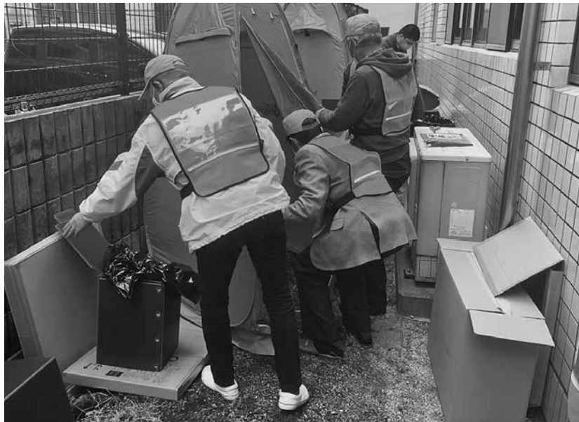
プラダントイレの組み立て
