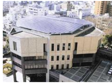
徳島市庁舎太陽光発電システム
