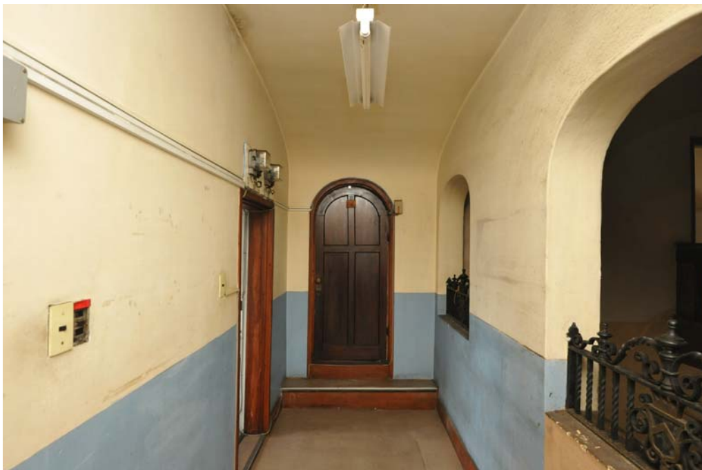
206 3階南側廊下 西向き
