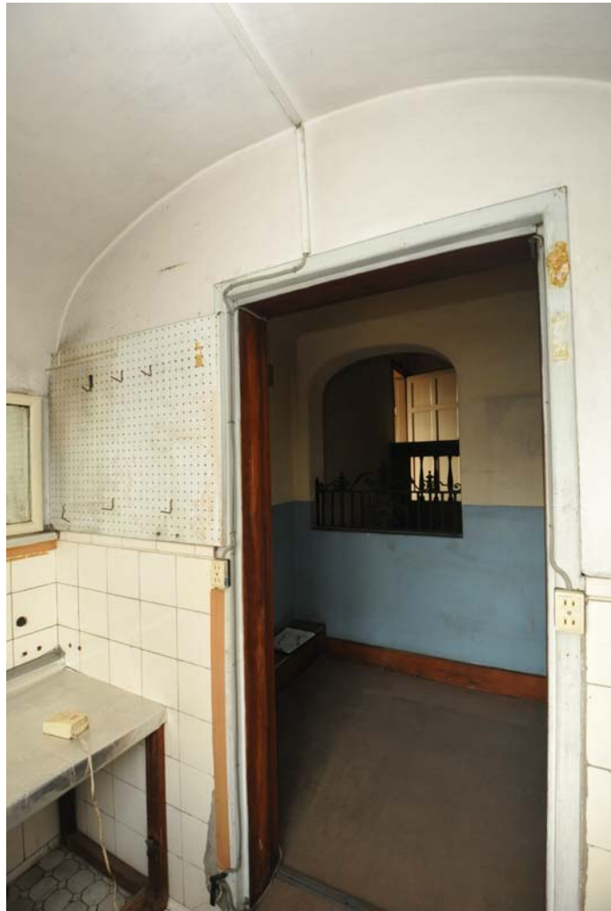
219 3階洗面室 北西向き
