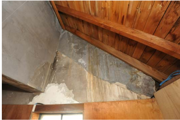
197 3階温罐室 東面上側
