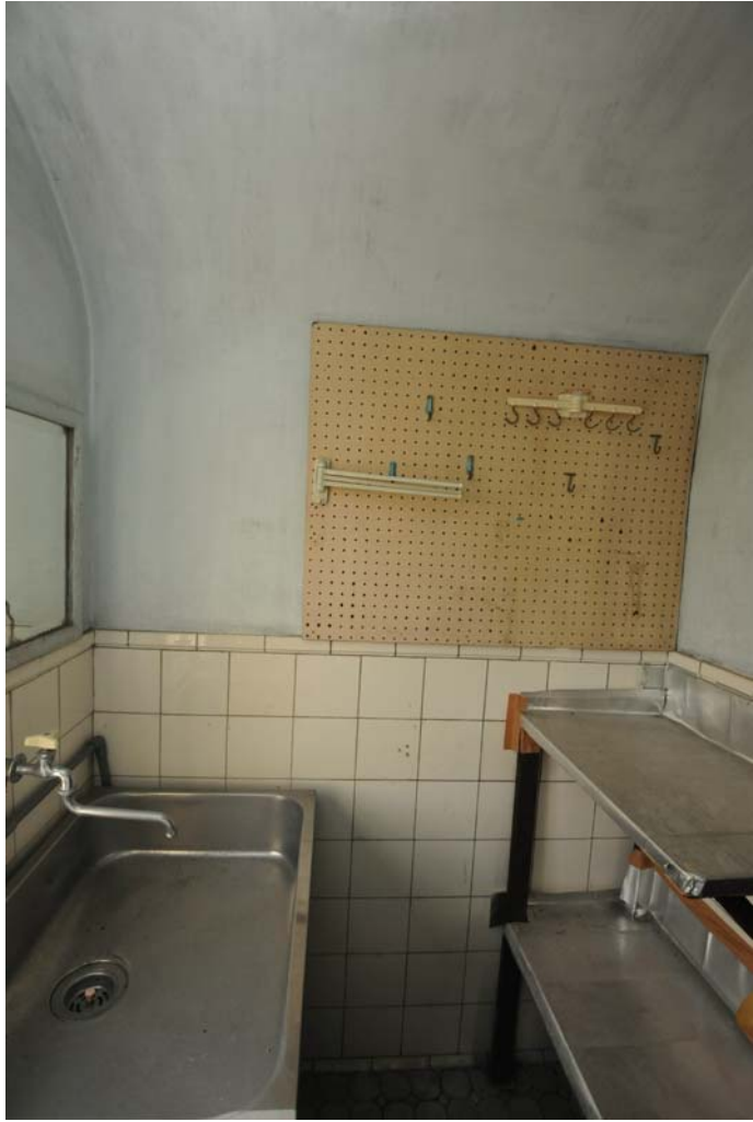
208 3階洗面室 西面
