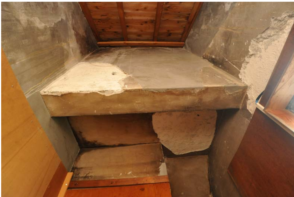
199 3階温罐室 天井
