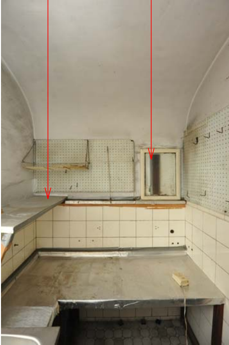
214 3階洗面室 西面
