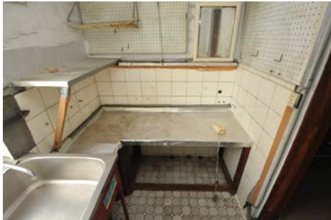
218 3階洗面室 流し台
