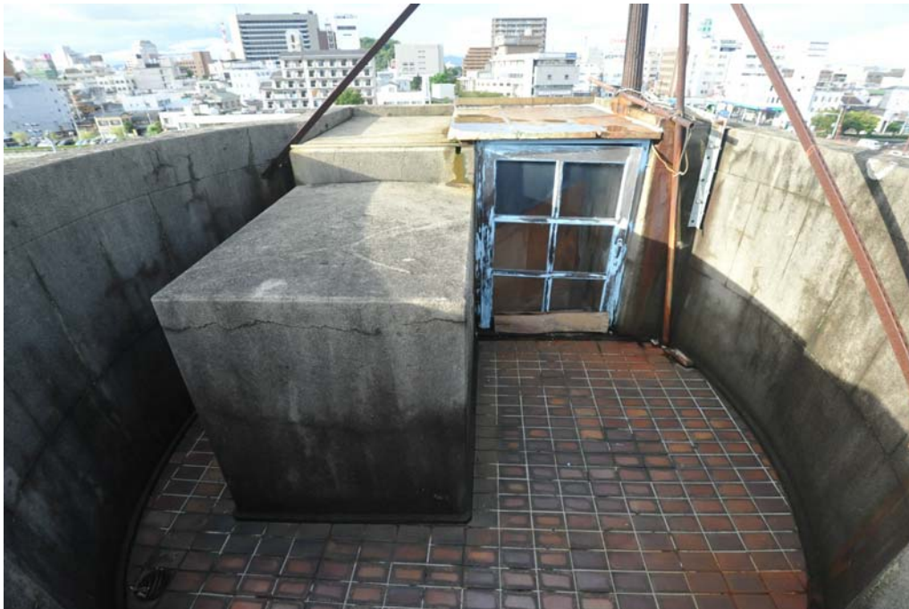
241 塔屋屋上 北向き
