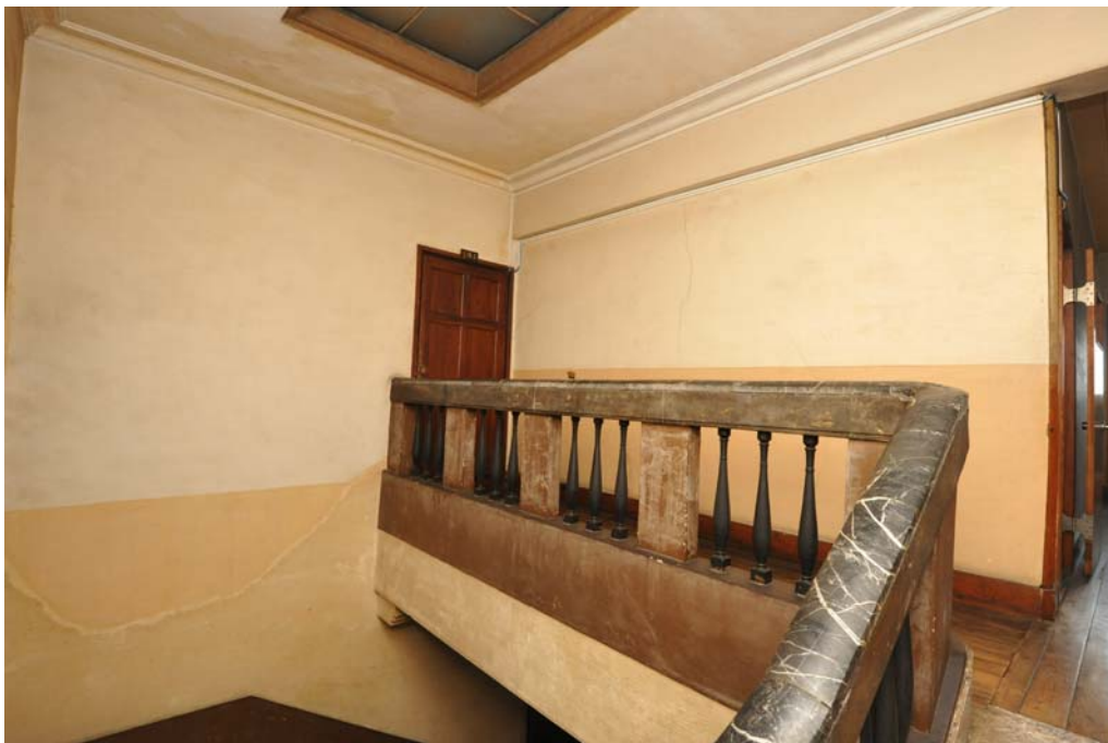
179 3階階段室 北西向き
