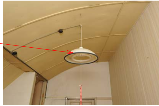
229 3階小供室（北）天井
