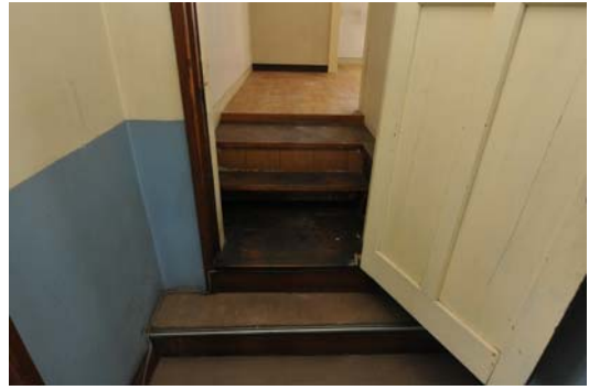
225 3階小供室（南） 出入り口段差2
