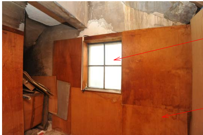
198 3階温罐室 東面下側
