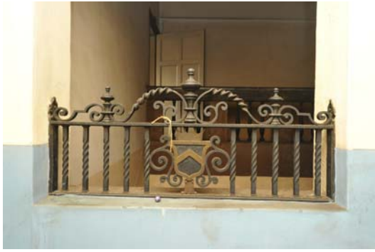
203 3階南側廊下 鉄製手摺
