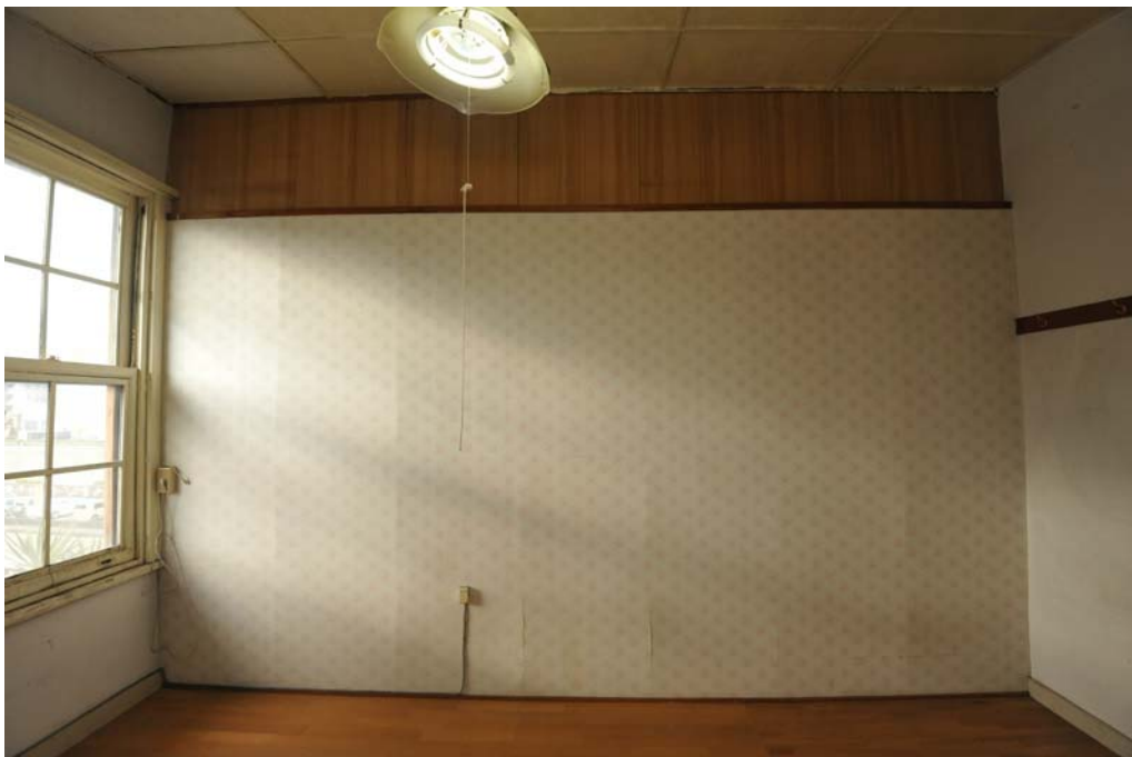
223 3階小供室（南）北面
