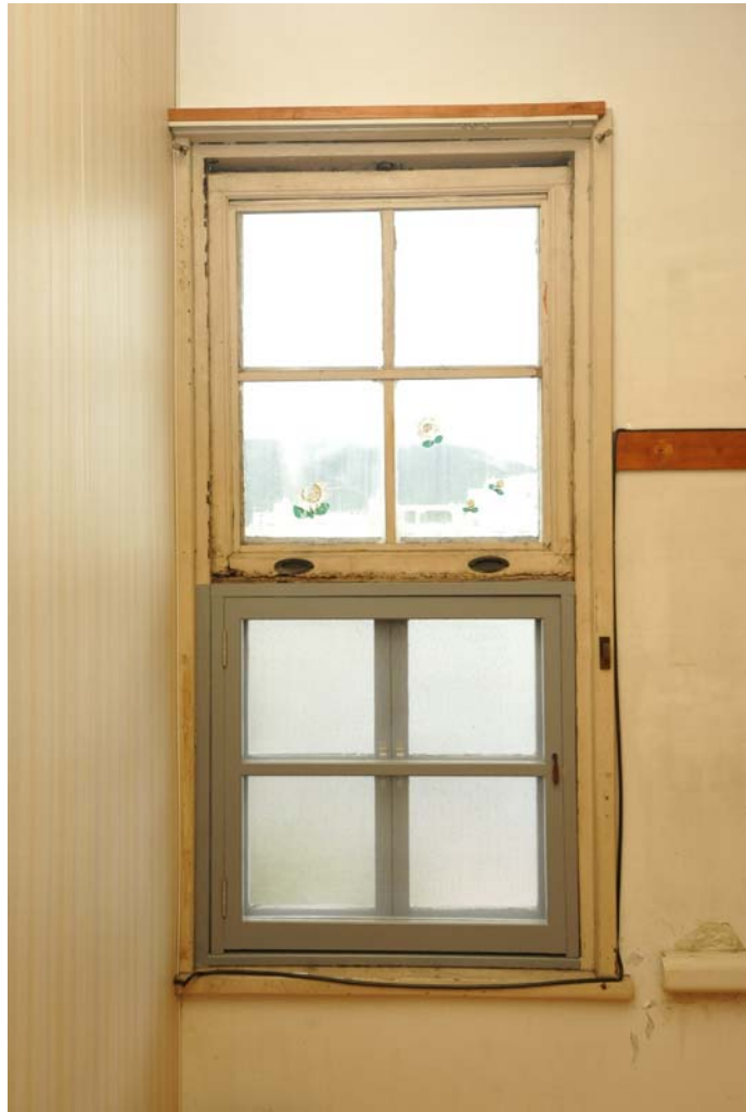
235 3階小供室（北）上下窓
