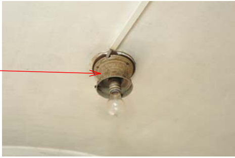
217 3階洗面室 天井
