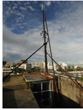
240 塔屋屋上 避雷針
