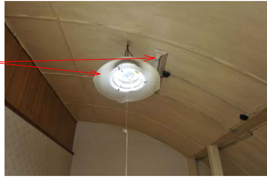
221 3階小供室（南）天井
