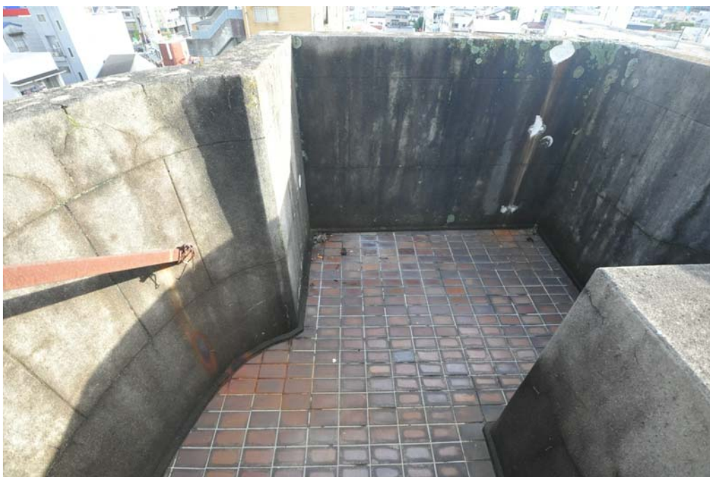
242 塔屋屋上 南向き
