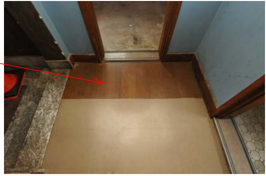
204 3階南側廊下 東端床面
