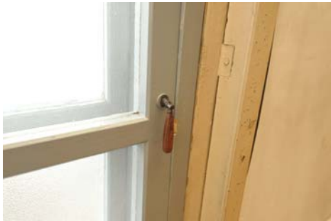
234 3階小供室（北）上下窓鍵
