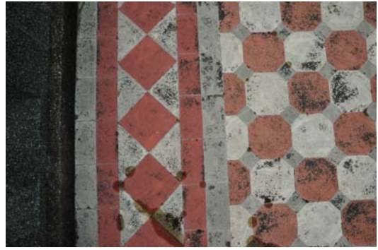
171 3階ベランダ セメントタイル
