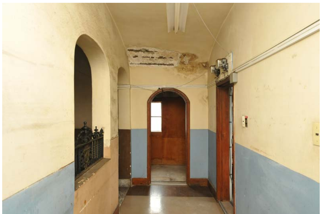
202 3階南側廊下 東向き
