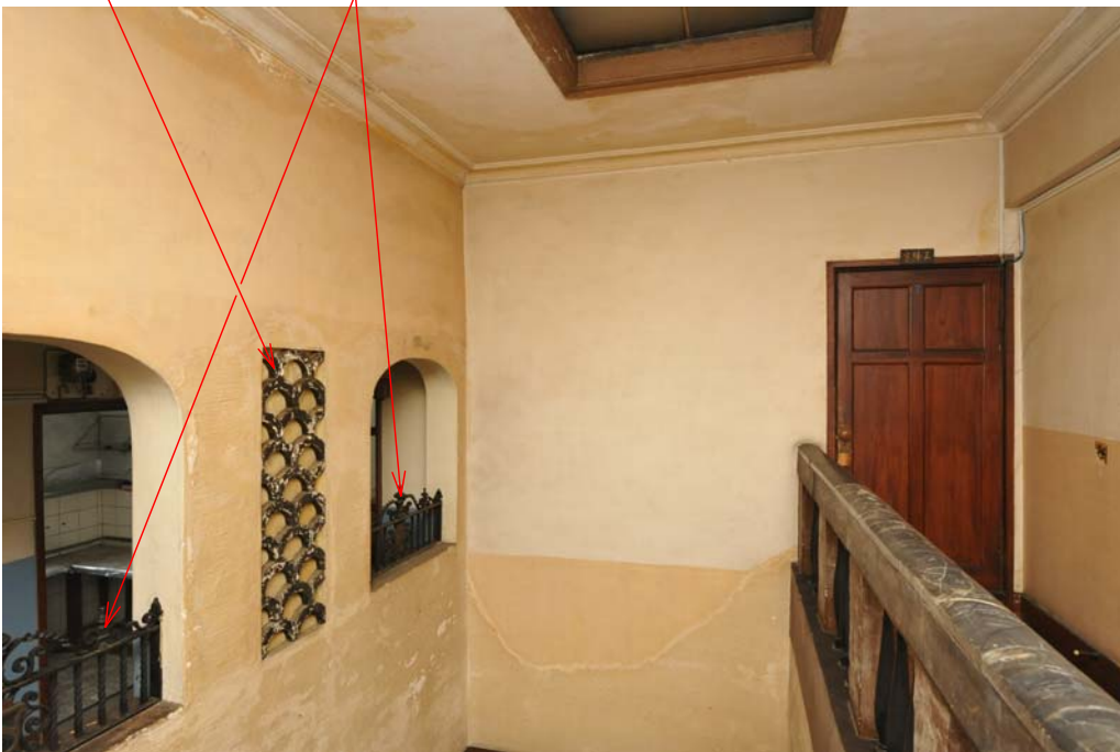
176 3階階段室 西面
