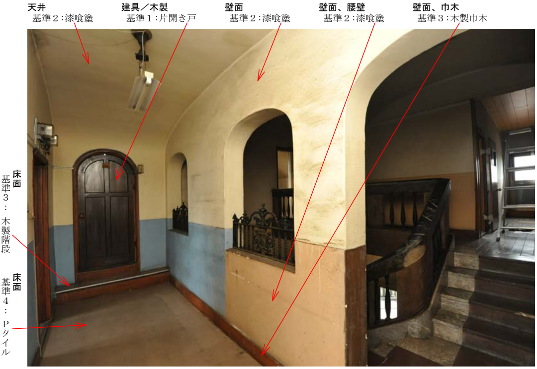
201 3階南側廊下 北西向き
