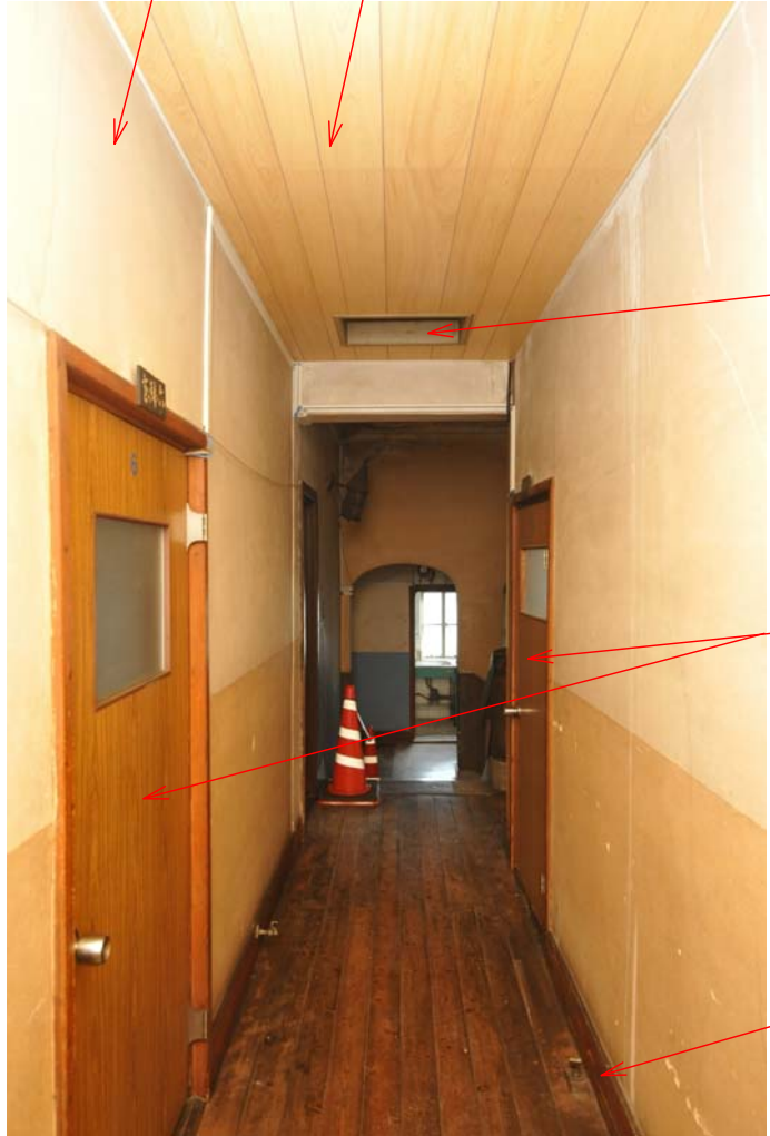
194 3階北側廊下 南向き
