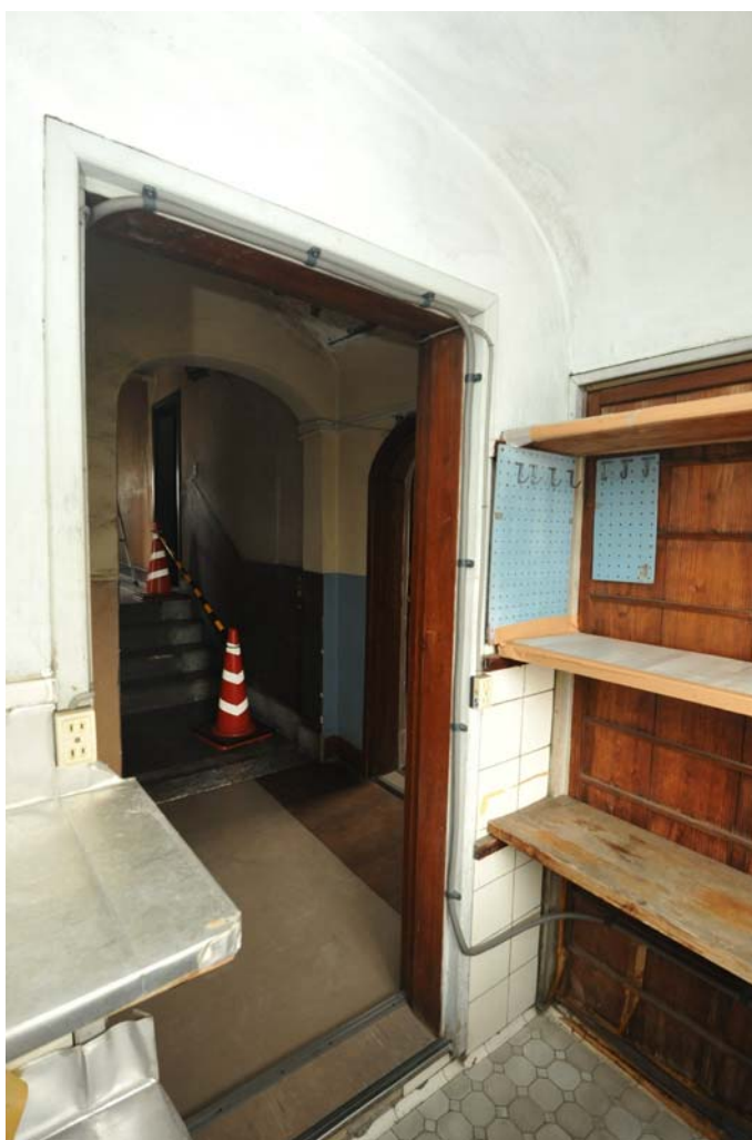
212 3階洗面室 北東向き
