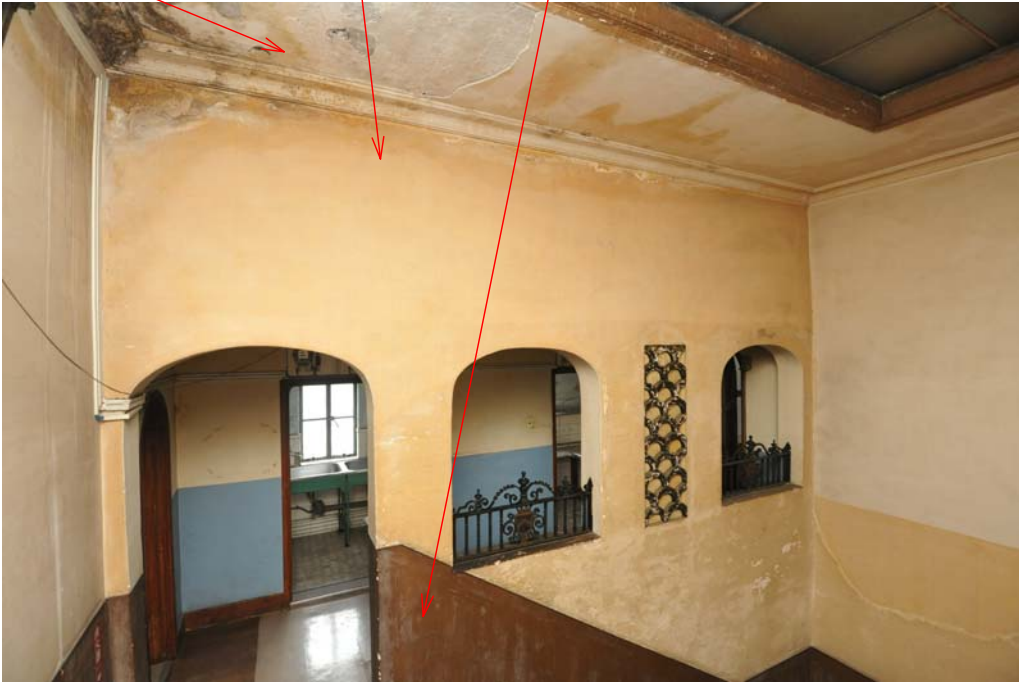
175 3階階段室 南面
