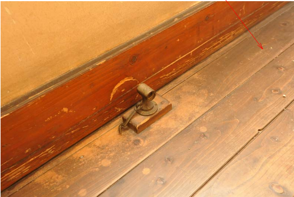
195 3階北側廊下 戸当たり
