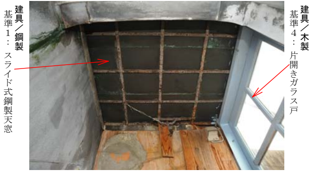
237 塔屋階段室 塔屋出入口
