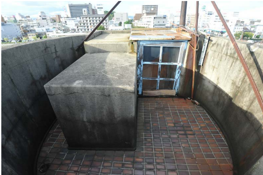
塔屋屋上北面
