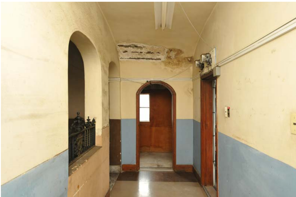
南側廊下東面
