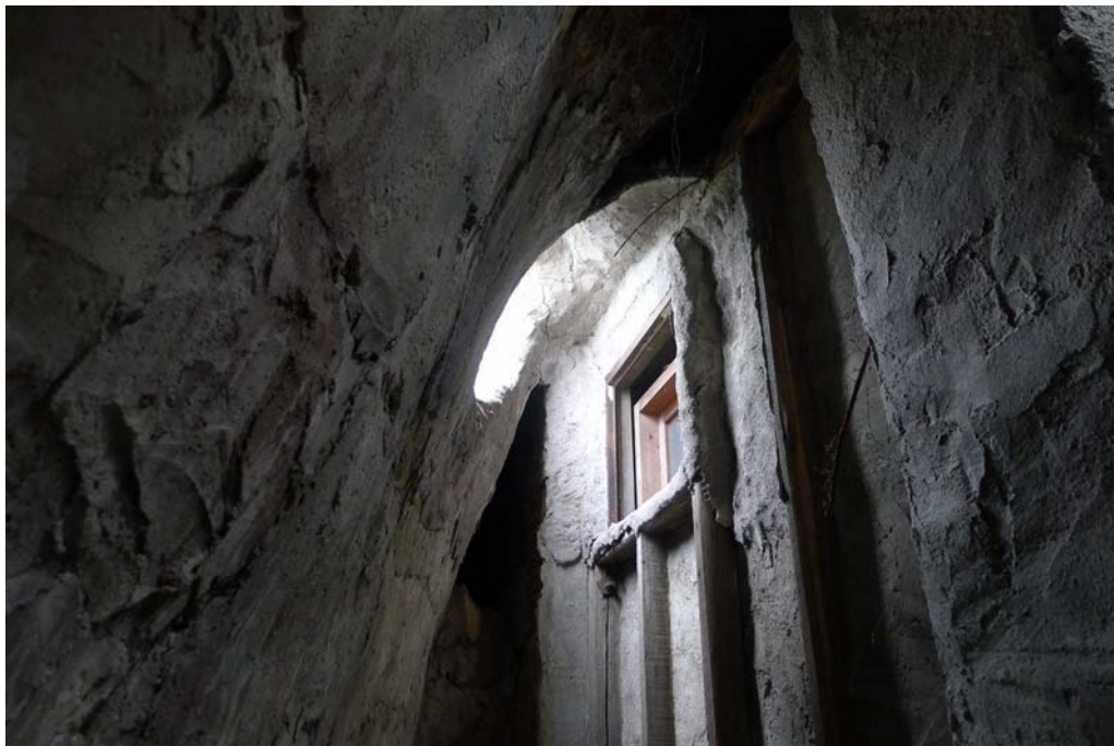
岩屋内部(背面側)
