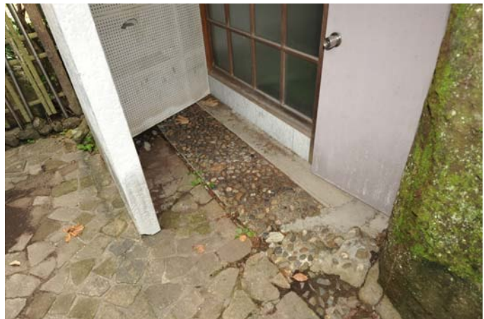
個室(中央)出入口床面
