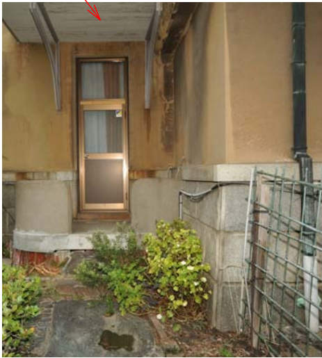
南面西側基礎付近
