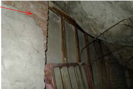
岩屋内部(背面側)煉瓦壁
