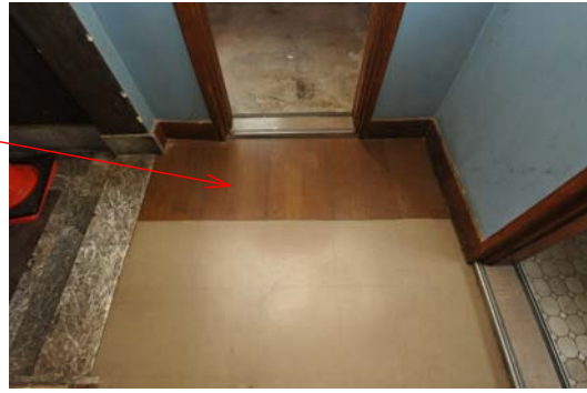
南側廊下東端床面
