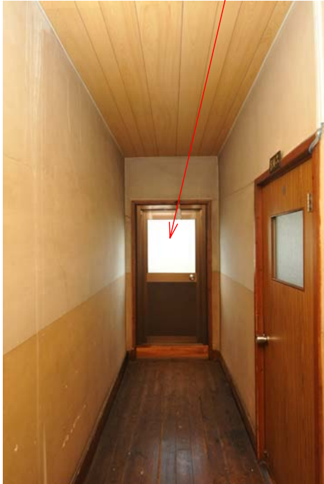
北側廊下北面
