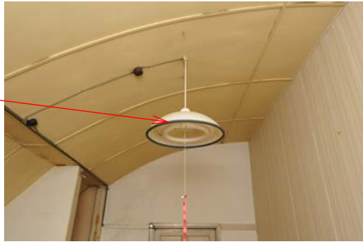
小供室(北)天井
