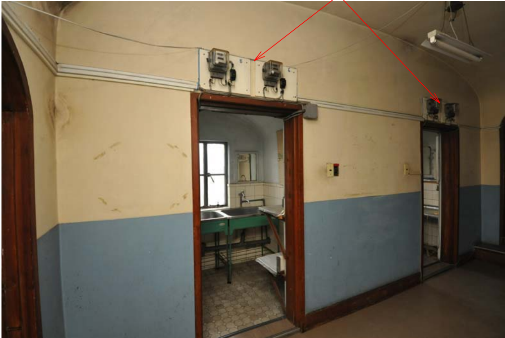
南側廊下南面
