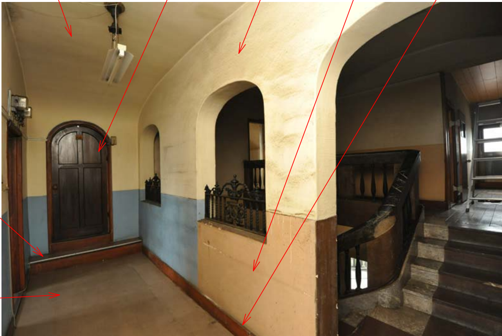
南側廊下北西面
