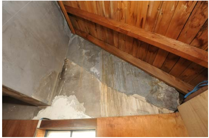
温罐室東面上側
