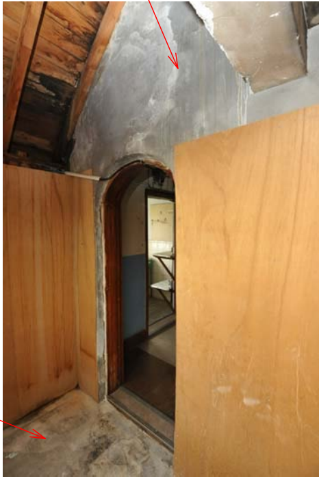
温罐室南西面
