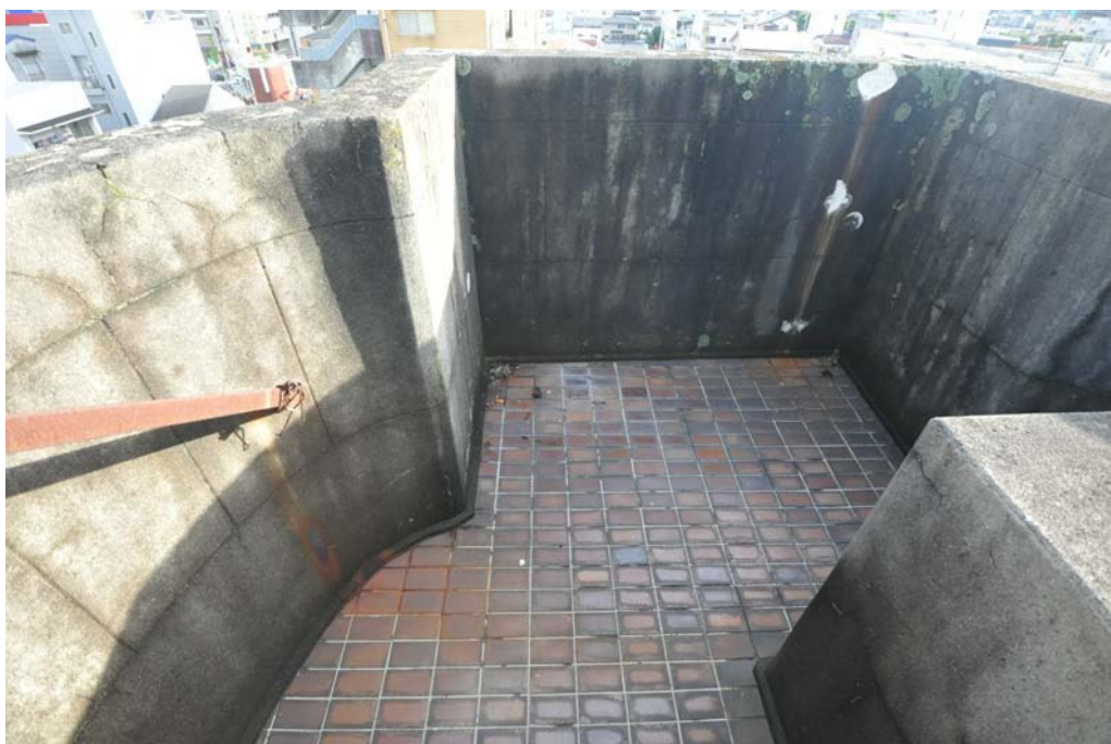
塔屋屋上南面
