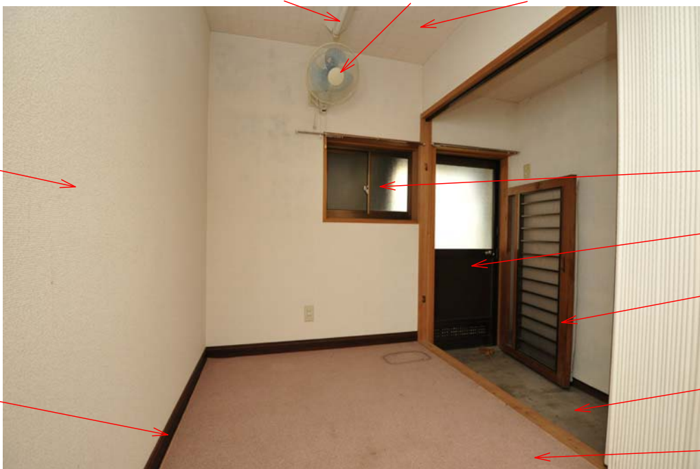
岩屋個室(南)東面
