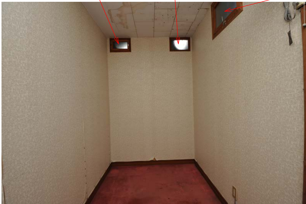
岩屋個室(北) 西面
