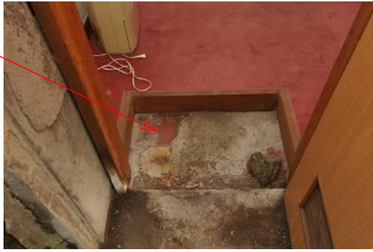
岩屋個室(北) 出入口床面
