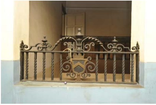
南側廊下鉄製手摺
