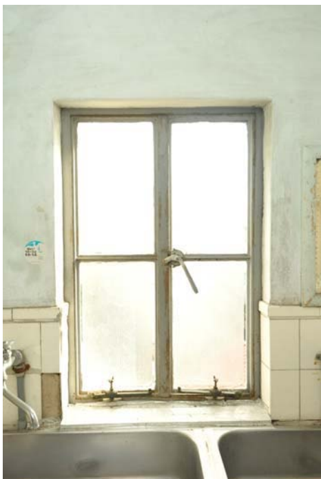
洗面室両開き窓
