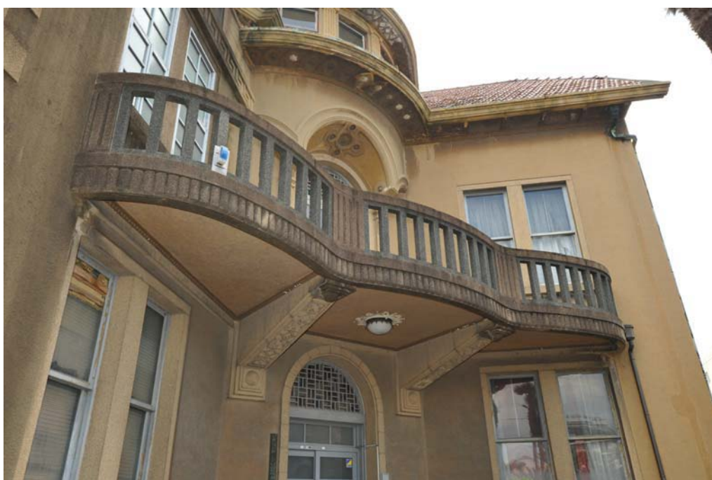
北面2階バルコニー見上げ
