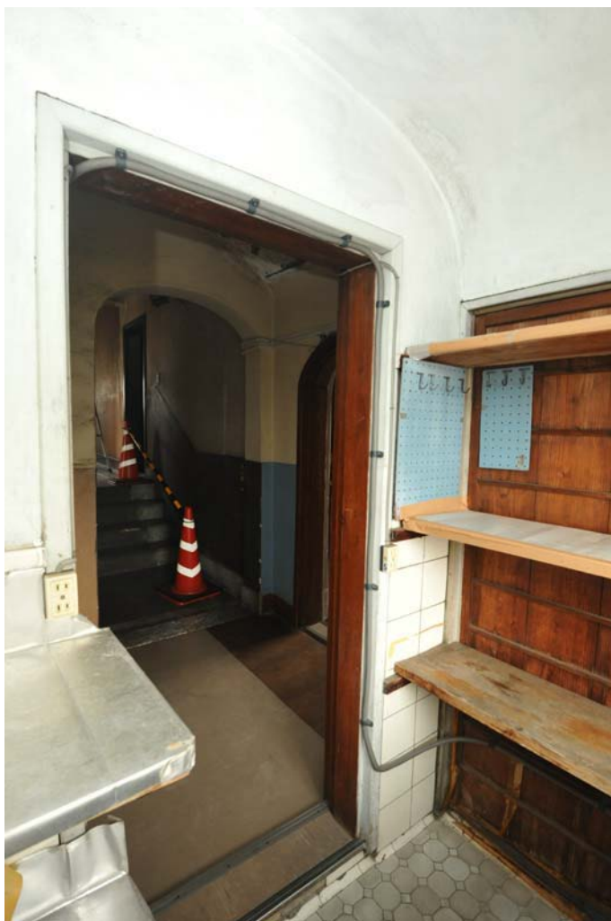
洗面室北東面
