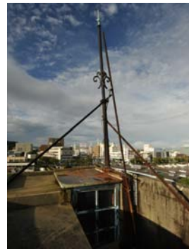
塔屋屋上避雷針
