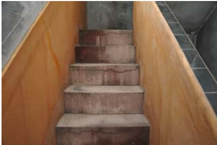
25 鉄筋コンクリート階段の亀裂 鉄筋コンクリート階段の蹴込部分、横方向に一定の亀裂が生じている。
