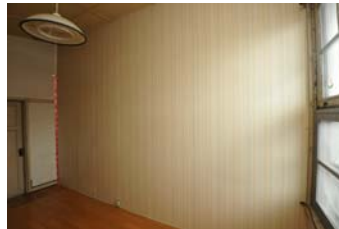
小供室(北)間仕切り
