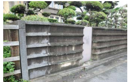
12 塀（北東）の切断痕 前面道路拡幅時に塀を後退させた際の処置と考えられる。
