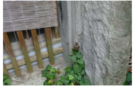
3 扉金具の残存 現在は窓に改変されている。
