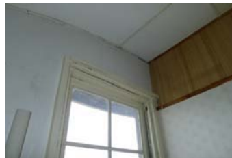
小供室(南)カーテンレール カーテンレールが間仕切りを貫いて北側とつながっている。
