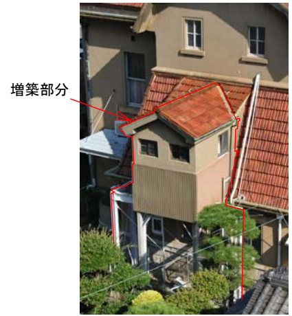
南側外観写真 便所は2階洗面室に接続するように増築されている。足元は鉄骨で立ち上げられている。
