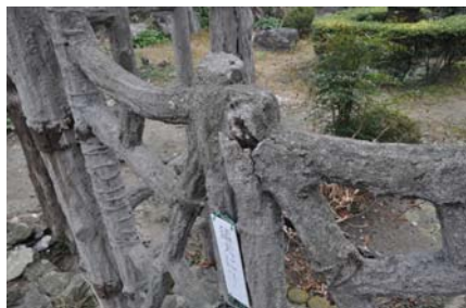
22 庭門コンクリートの爆裂 鉄筋が腐食膨張し、コンクリートが爆裂、剥落している。
