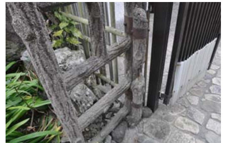
20 裏庭門コンクリートの爆裂 鉄筋が腐食膨張し、コンクリートが爆裂、剥落している。
