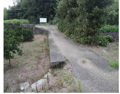
⑥コンクリート舗装
