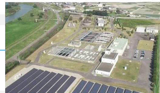
浄水施設（第十浄水場）
