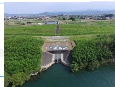
取水施設（取水口）
