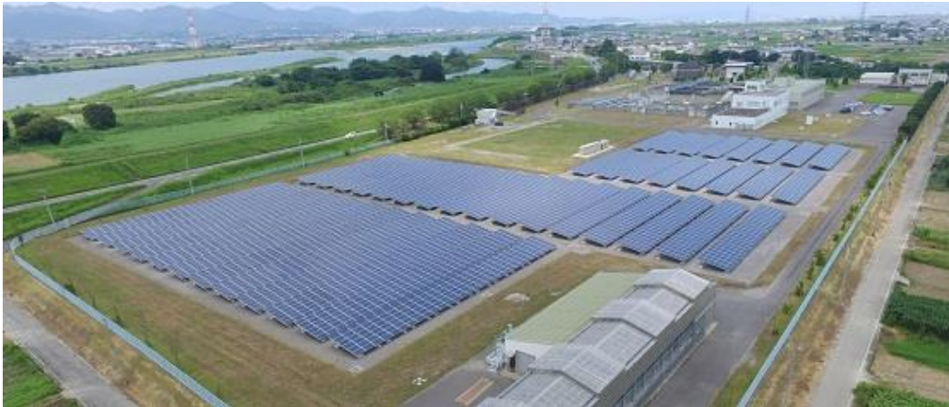
図 6.5 太陽光発電設備（第十浄水場）
