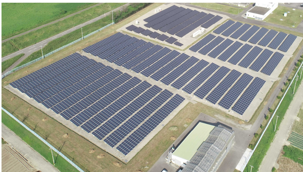
図 2.2 大規模太陽光発電設備と高効率天日乾燥施設
