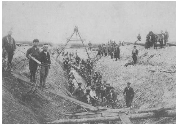
導水管を埋設する伏越工事(中鮎喰 1925年)
