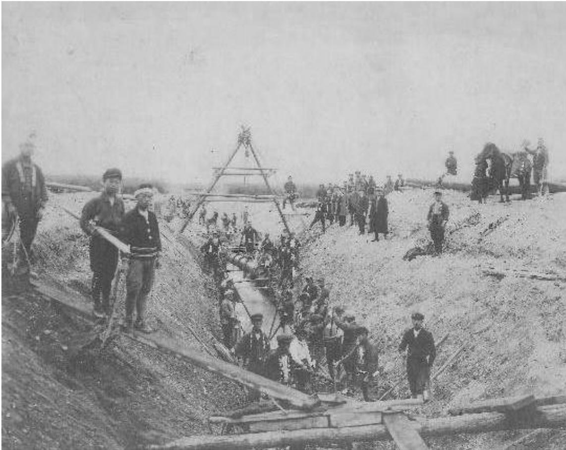
導水管を埋設する伏越工事(中鮎喰1925年)
