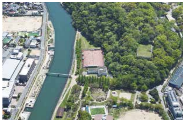
西の丸配水場・城山配水池
