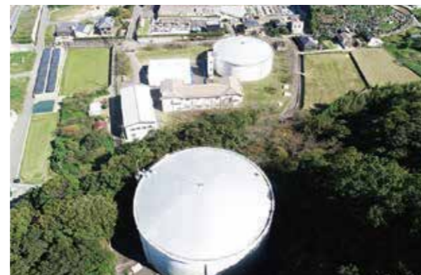
法花谷配水場・配水池
