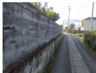
擁壁上のブロック塀
