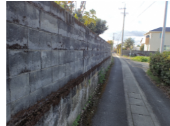
擁壁上のブロック塀
